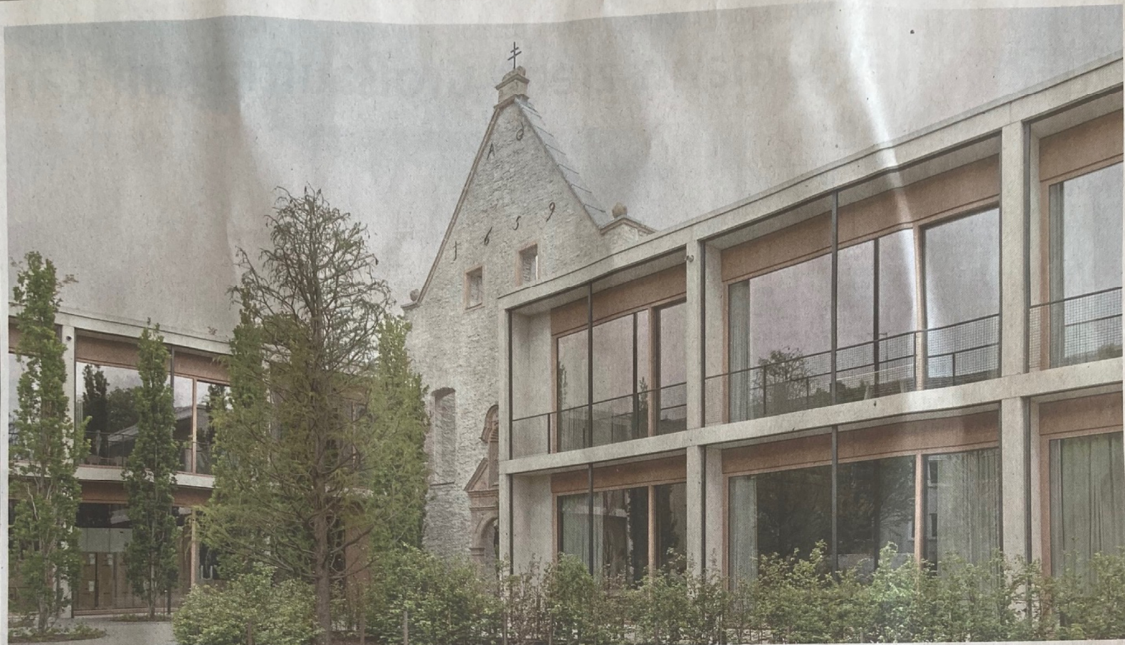
Alt und Neu in beeindruckender Symbiose: Ein zentrales Element des ehemaligen Landeshospitals ist die Kapellenfassade, die heute als Haupteingang des Unternehmensitzes der Unternehmerfamilie Jacoby dient. 150 Arbeitsplätze sind hier für die Firmen Rico Design, Idee, Kreativmarkt und Wolle Rödel entstanden. Foto: Simon Menges
